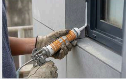
Instalasi Kaca Jendela Eksterior
