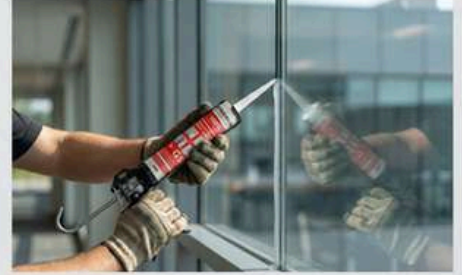
Instalasi Kaca Jendela Interior
